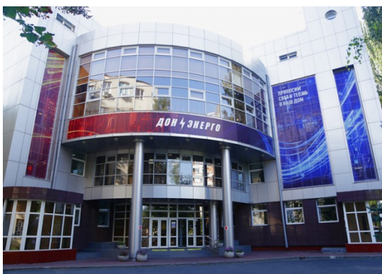
Рисунок 1 – Предприятие НМЭС АО «Донэнерго»
